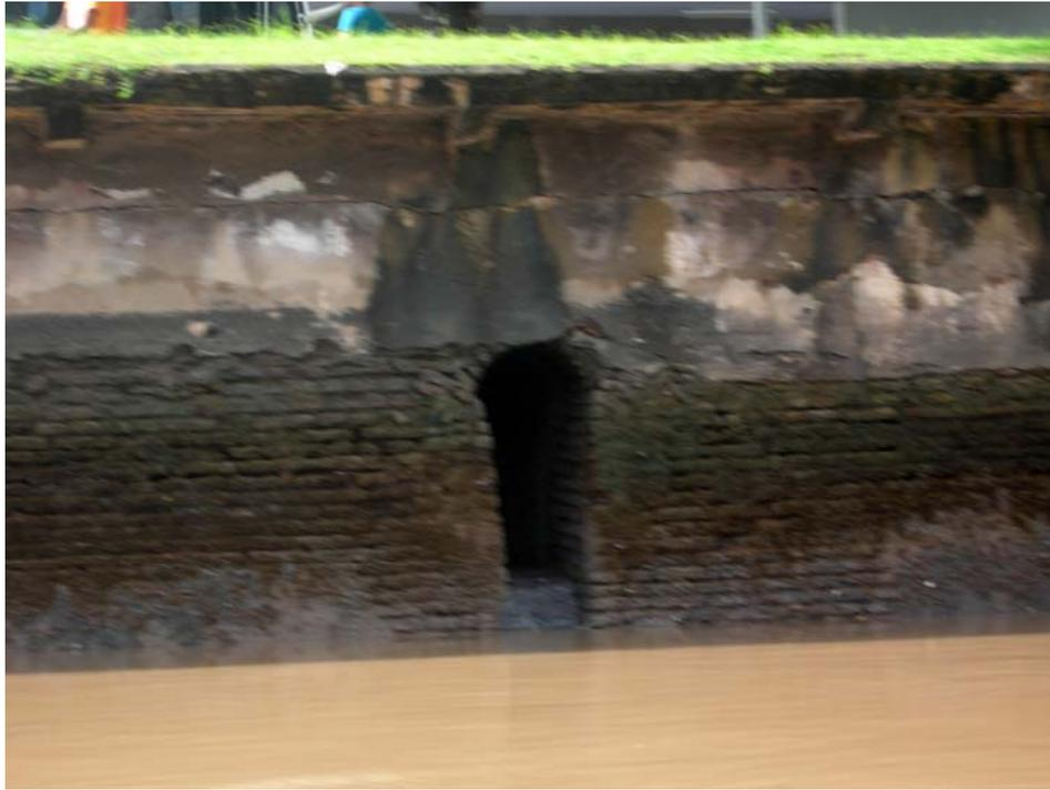
Figura 10: Galeria de águas pluviais nas margens do Rio Capibaribe.
