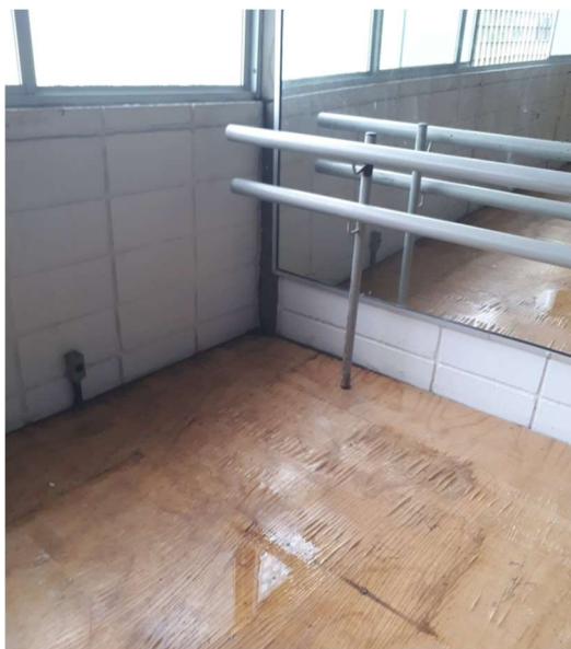
Foto 02 - sala 01 – deterioração piso
