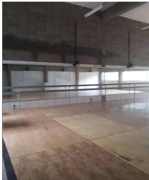
Foto 05 - sala 03 – infiltração paredes
