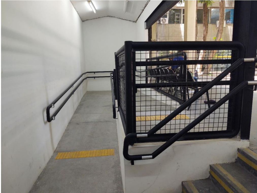
Rampa com corrimão e guarda corpo no departamento de música
