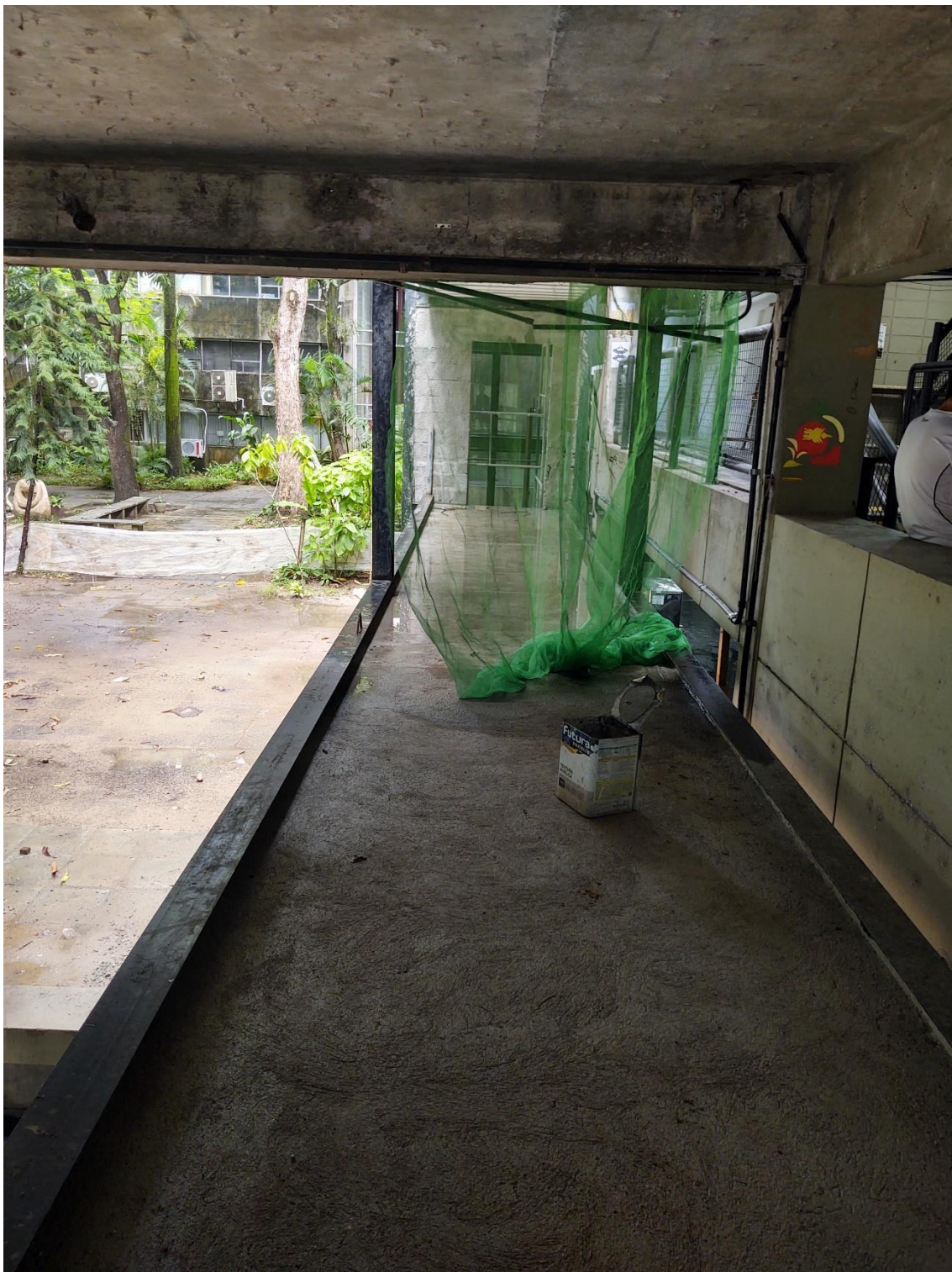
Estrutura metálica do elevador e passarela
