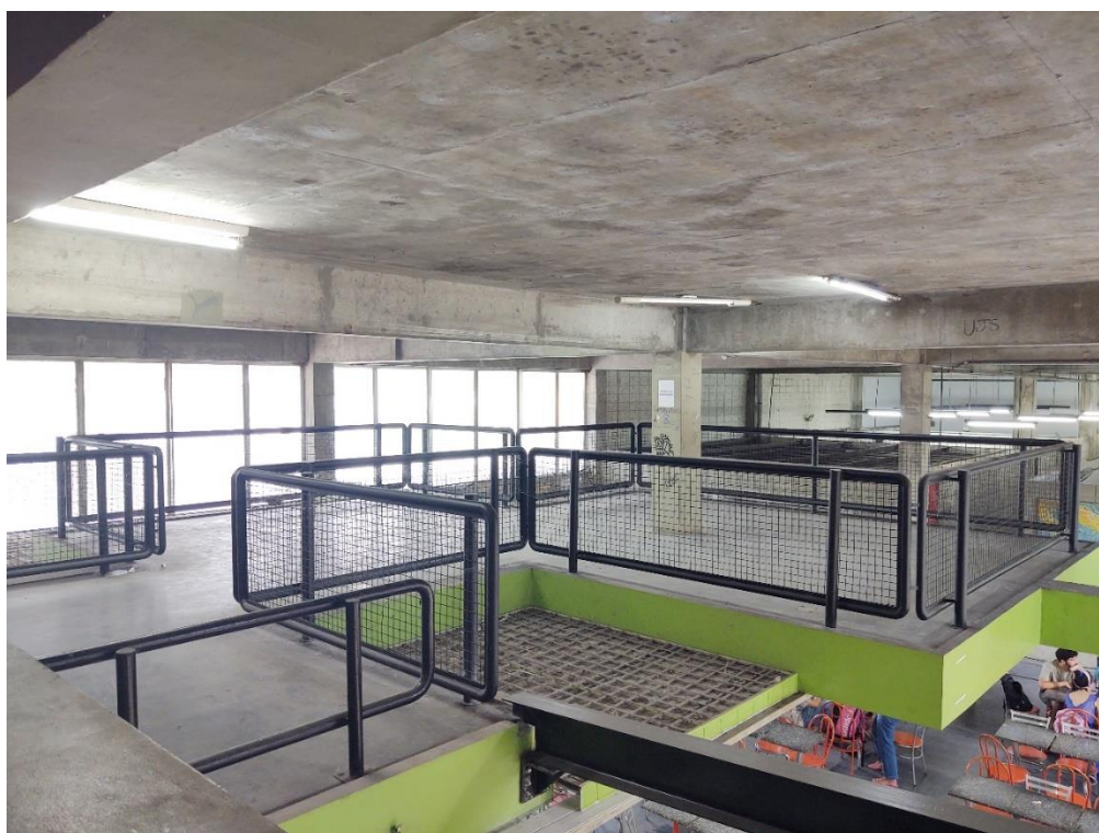
Instalação de guarda corpo na laje em cima da cantina
