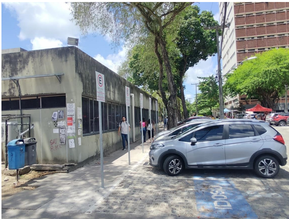
Execução de vagas acessíveis e instalação de placas
