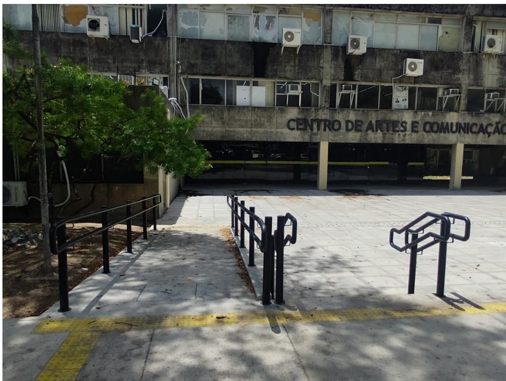
Construção de rampa e escada, instalação de corrimão e piso tátil
