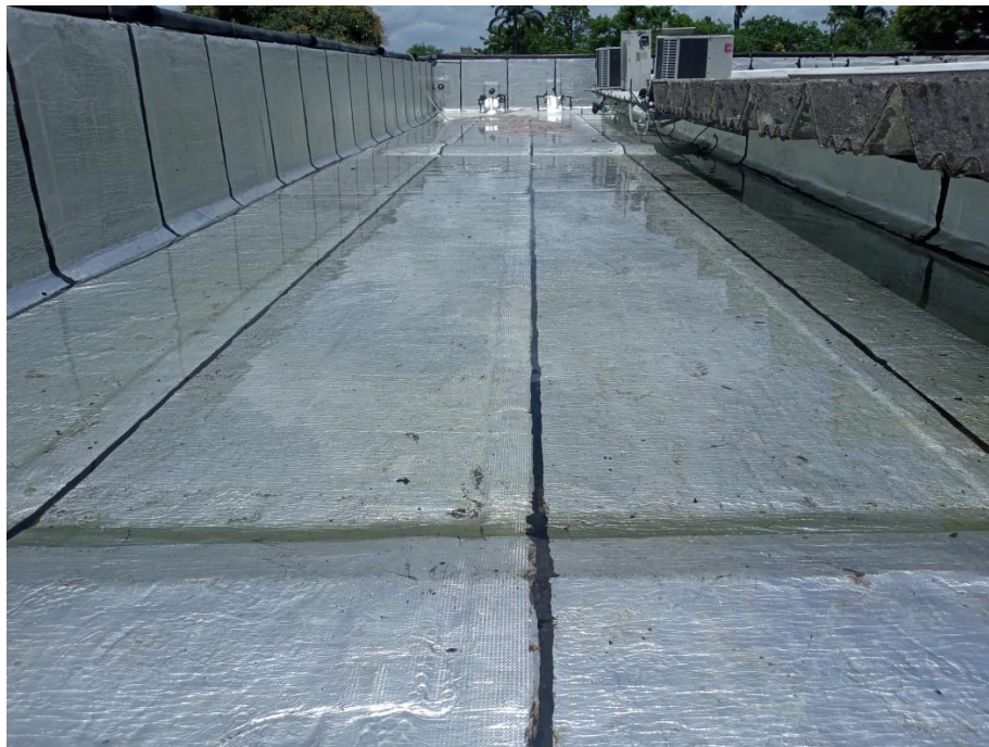
Figura 4: Vista final com aprovação da estanqueidade.
