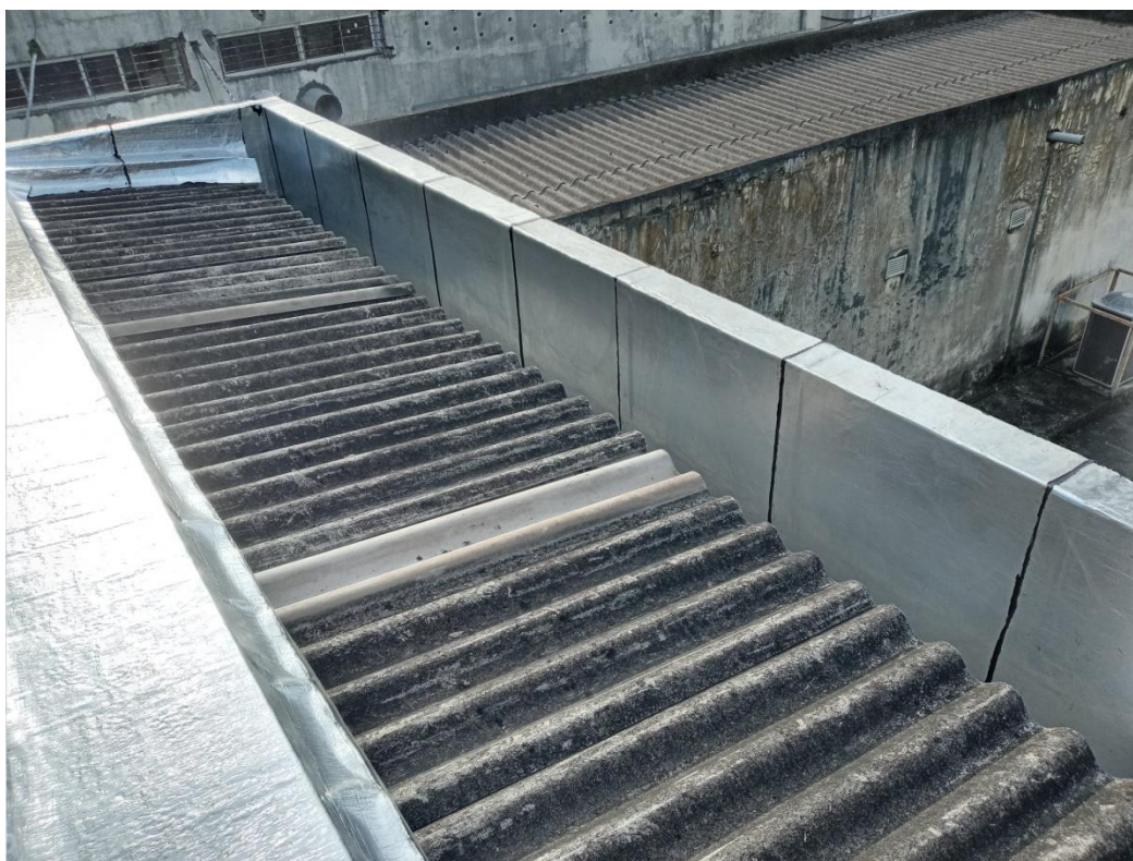
Figura 5: Impermeabilização dos rufos e platibanda da área de ampliação.
