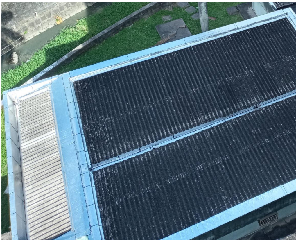
Figura 5: Impermeabilização dos rufos e calhas do setor norte.
