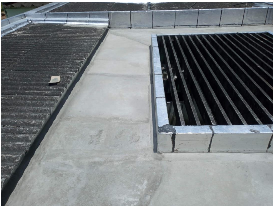
Figura 4: Proteção mecânica do setor central.
