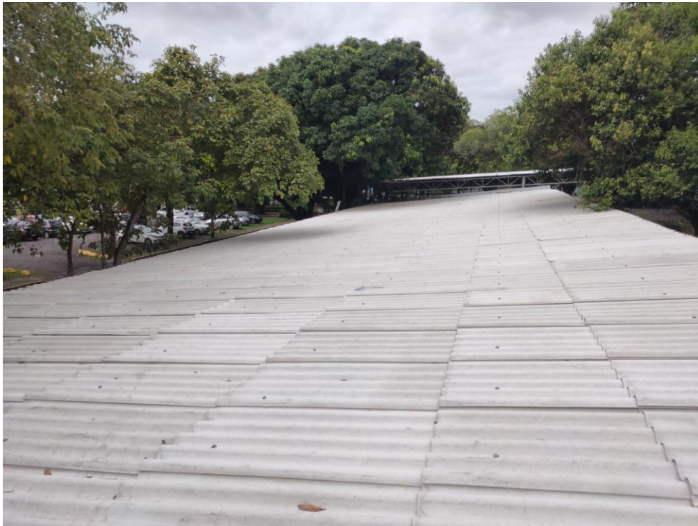
Figura 4: Cobertura executada vista lado Norte
