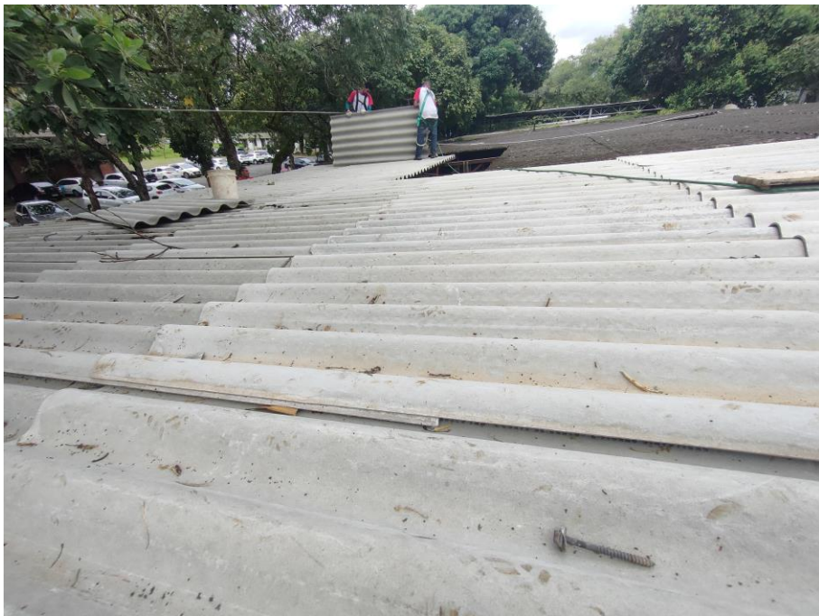
Figura 3 Execução da remoção e substituições das telhas vista lado Norte.
