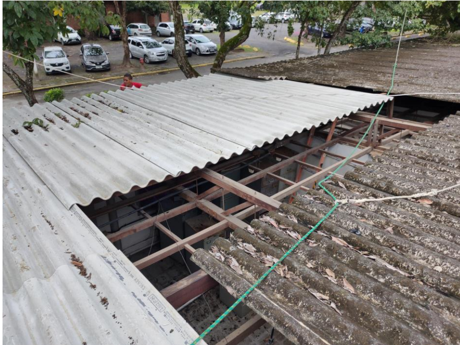
Figura 2: Execução da remoção e substituições das telhas da cobertura vista superior.
