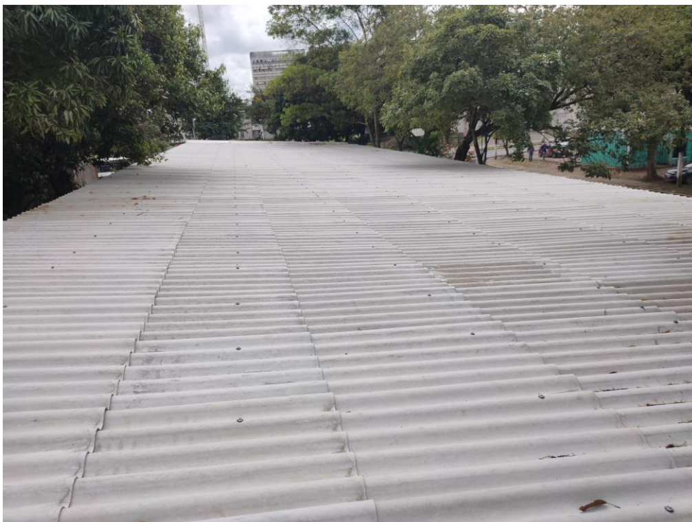
Figura 5: Cobertura executada vista ado Sul
