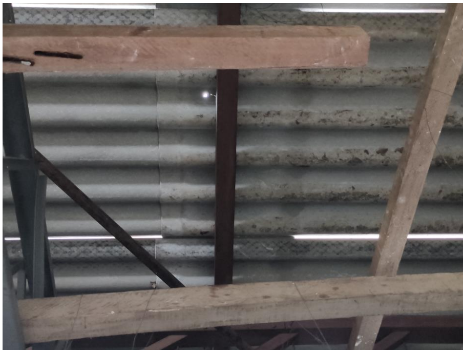
Figura 1: Vista inferior da cobertura.
