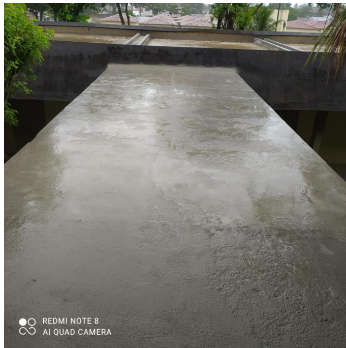
Figura 08: Impermeabilização passarela lado leste
