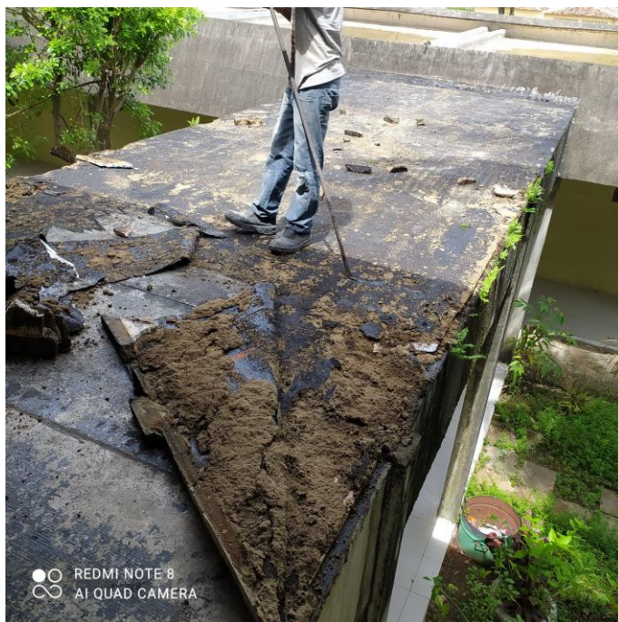
Figura 3: Remoção da impermeabilização passarela lado Leste.
