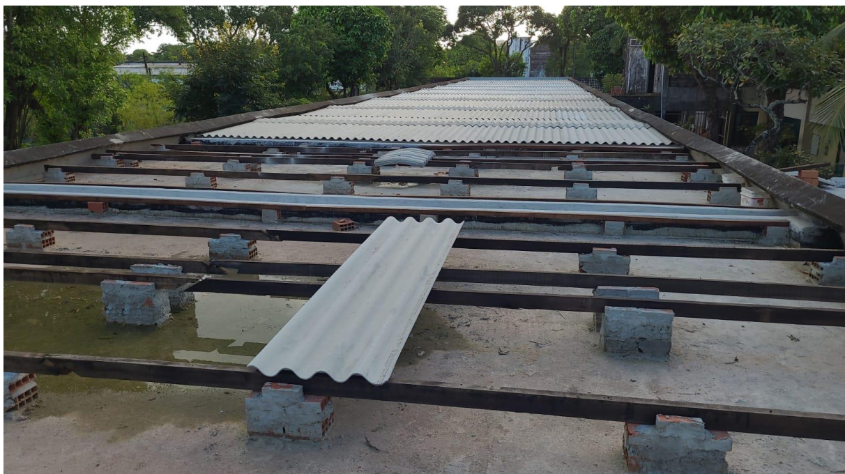
Figura 9: Impermeabilização e execução da cobertura vista para o lado Oeste
