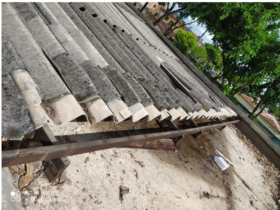
Figura 5: Remoção da cobertura oeste
