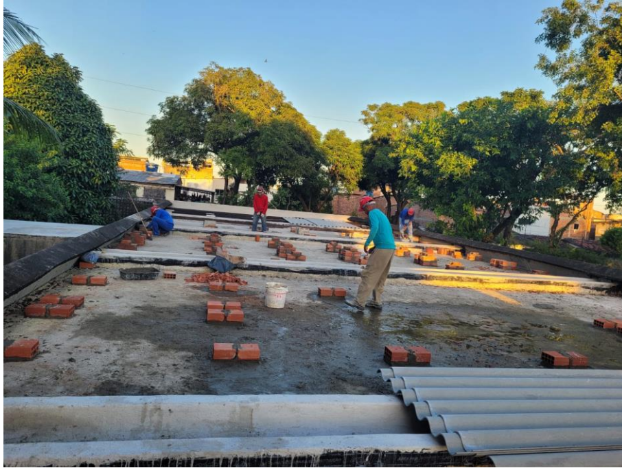
Figura 10: Imermeabilização e execução da cobertura vista para o lado Leste
