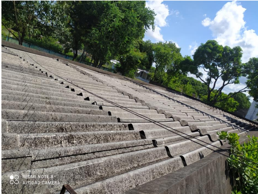
Figura 2: Vista geral da cobertura para intervenção, lado leste.
