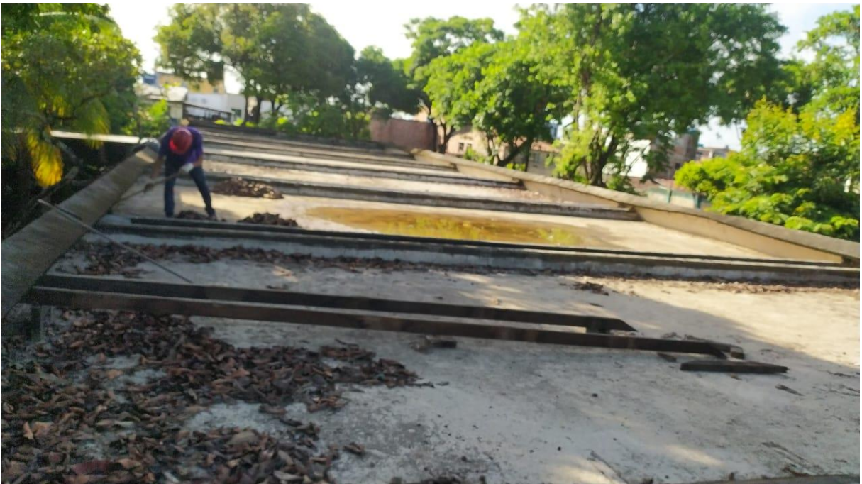
Figura 7: Limpeza e remoção de impermeabilização vista lado Oeste
