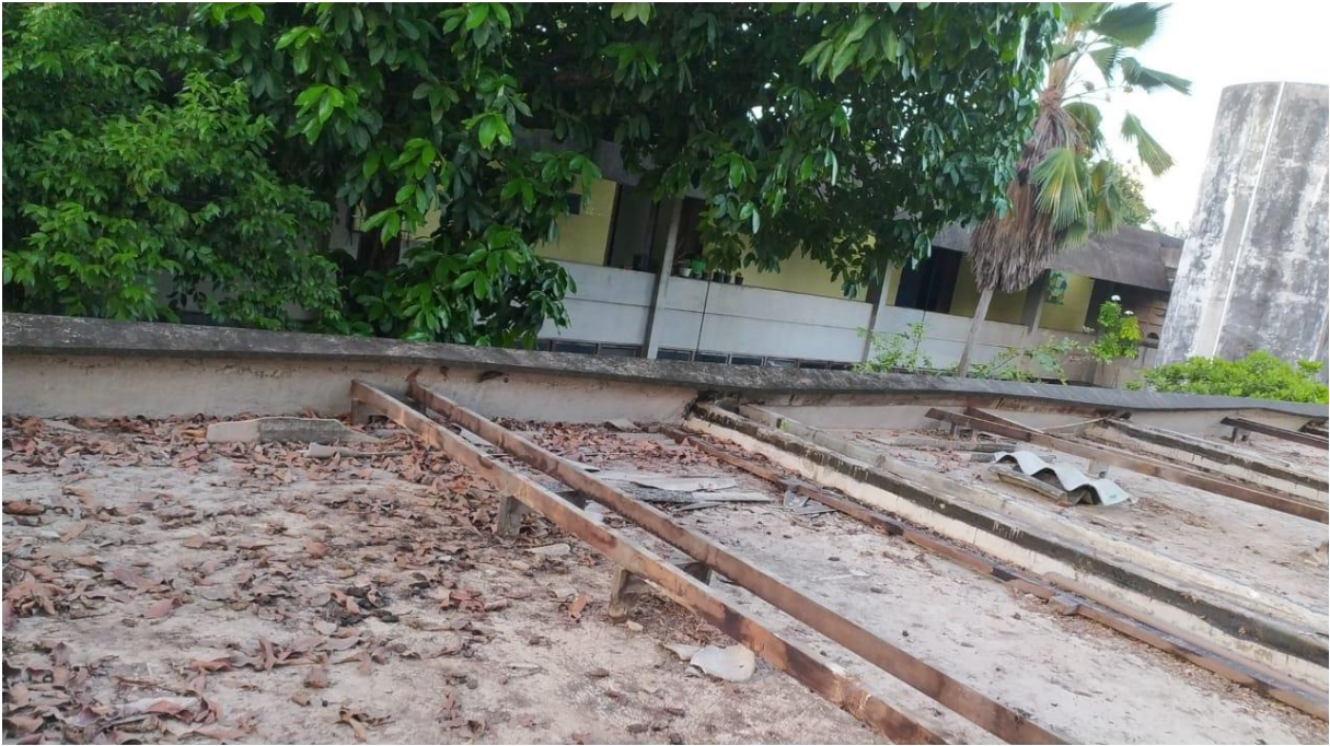
Figura 6: Limpeza e remoção de impermeabilização vista lado leste
