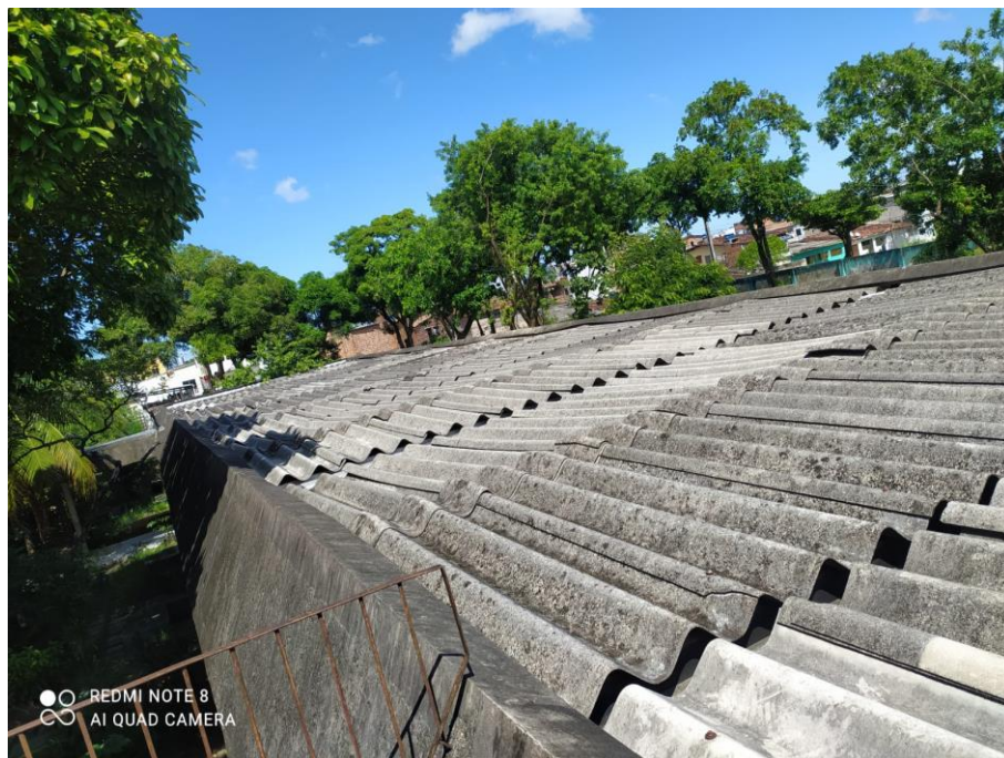
Figura 1: Vista geral da cobertura para intervenção, lado oeste.
