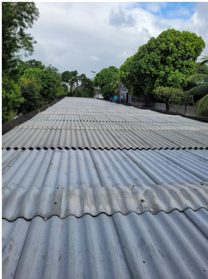
Figura 11: Vista para o lado Oeste da cobertura executada
