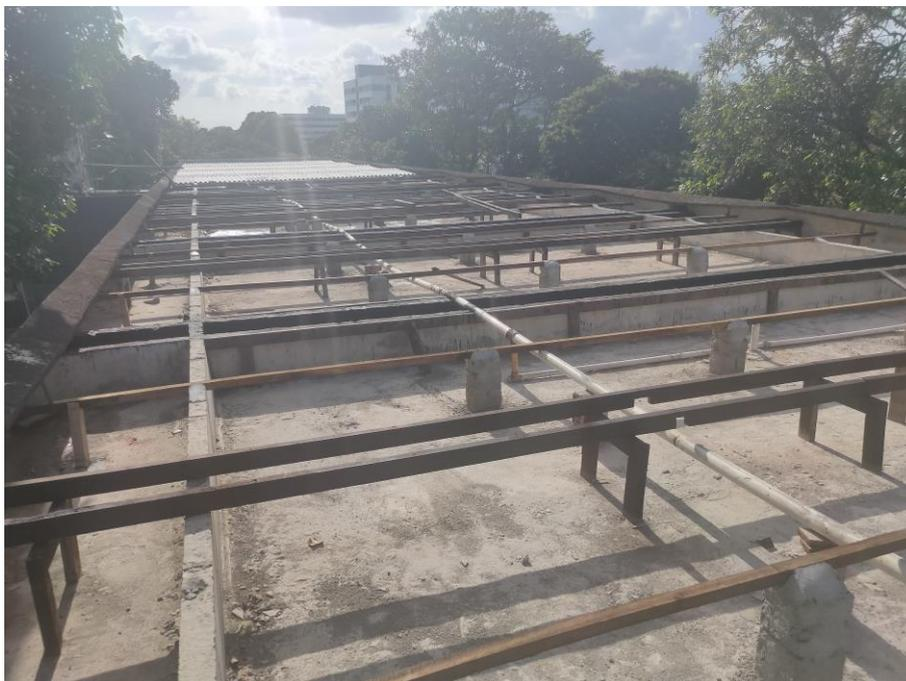
Figura 4: Execução de impermeabilização e cobertura lado Oeste
