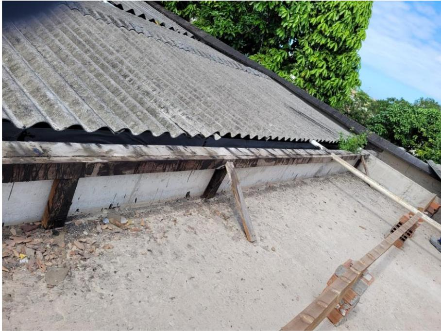
Figura 2: Remoção da impermeabilização, telhas e limpeza da cobertura lado Oeste
