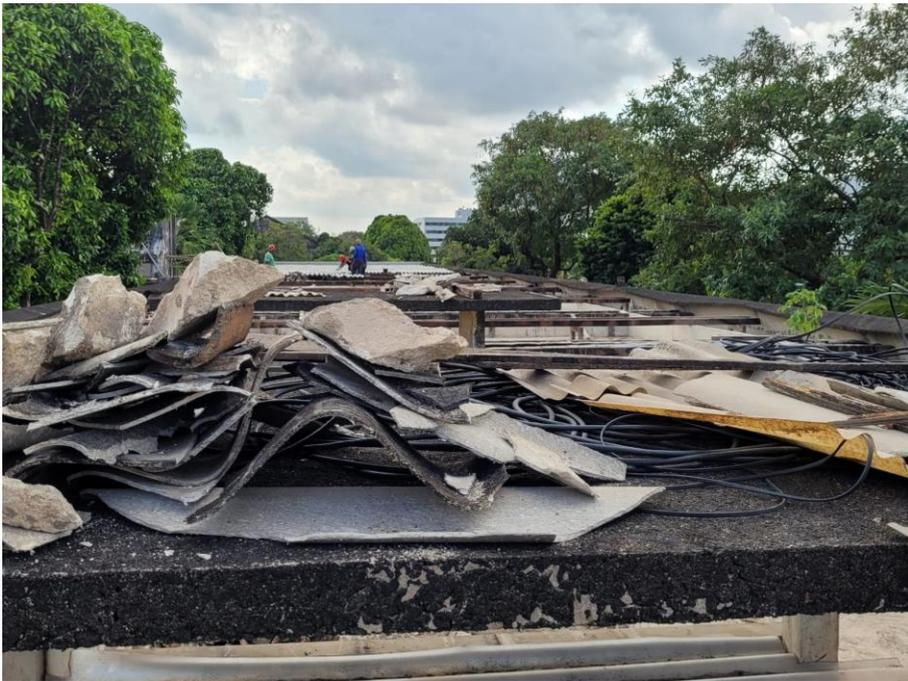
Figura 3: Remoção da impermeabilização, telhas e limpeza da cobertura lado Leste
