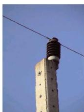
**Figura 2.1** – Sistema MRT. Um único condutor fase[34].
