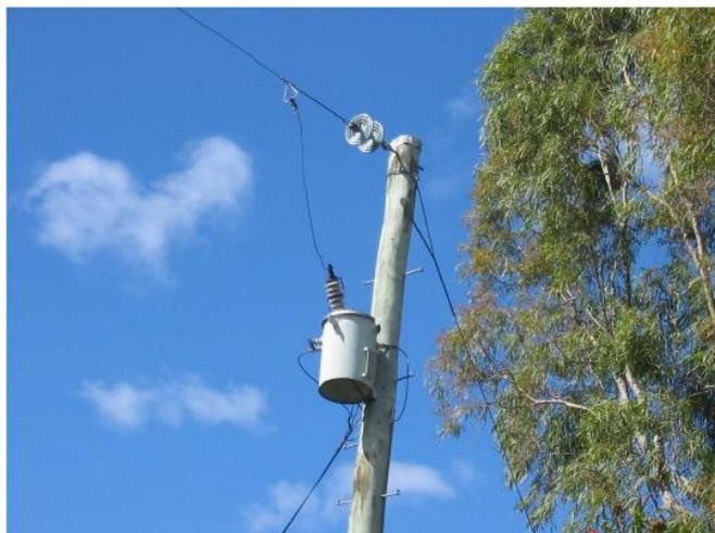
**Figura 1.1** – Transformador ligado a um sistema MRT para um consumidor [6].
