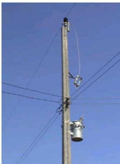
**Figura 2.2** – Transformador do Sistema MRT. Um único condutor fase[34].
