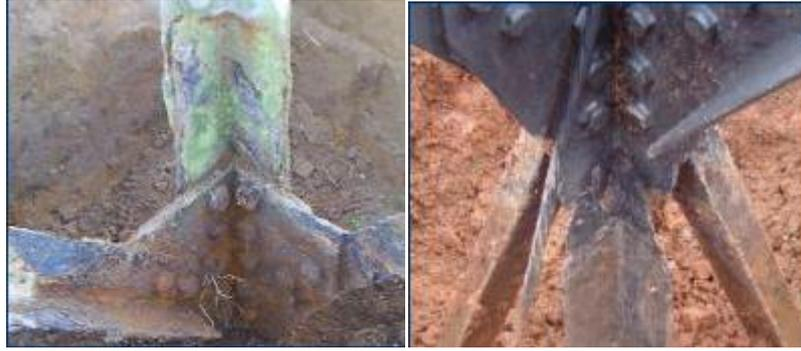
**Figura 11**– A corrosão na base das estruturas metálicas [21].
