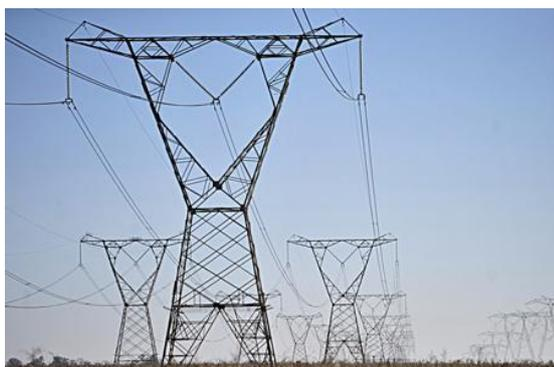
**Figura 8** – Torres de transmissão de nível de tensão 230kV.
