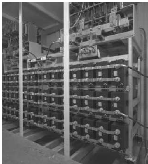
Figura 3.8 – Barramento CC de um DVR comercial [29].
