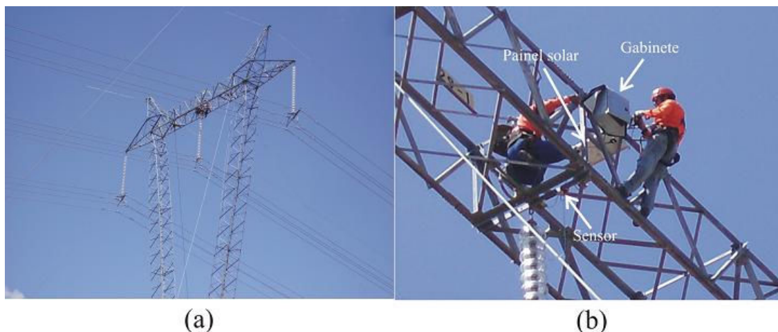
Figura 36 - a) Fotografia da torre escolhida para instalação do sistema 06 e (b) gabinete, painel solar e sensor do sistema 06 sendo instalados pelos eletricitistas.
