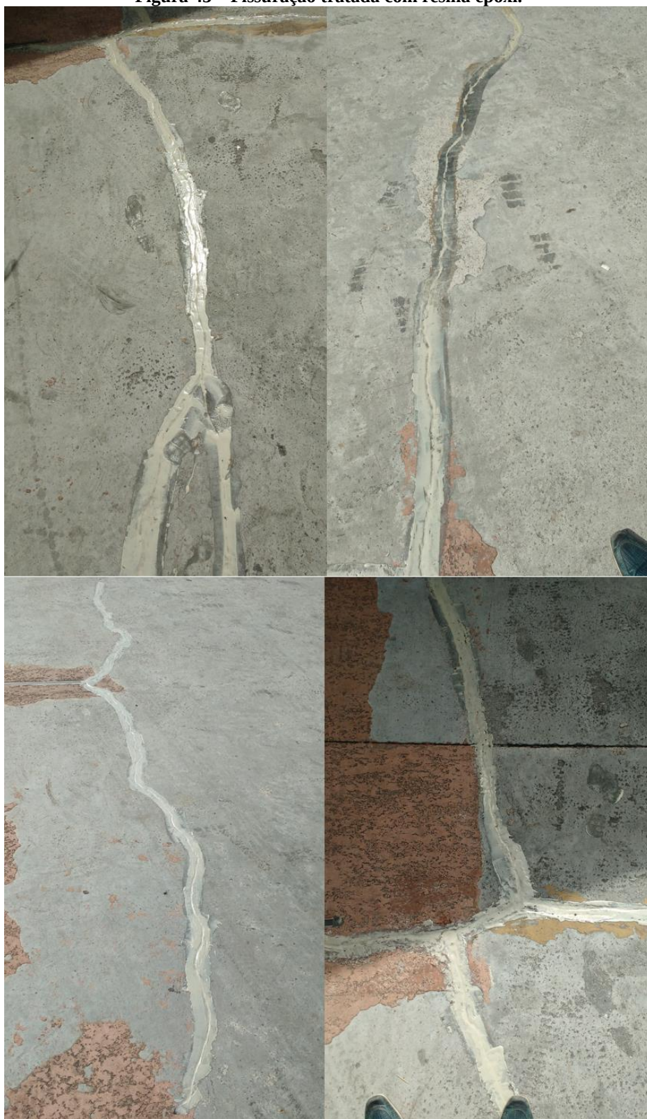
Figura 43 – Fissuração tratada com resina epóxi.
