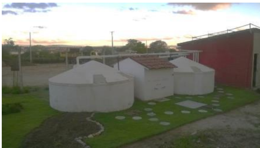
Figura 12: Instalação Experimental de Cisternas (IEC) do LEA-UFPE.
