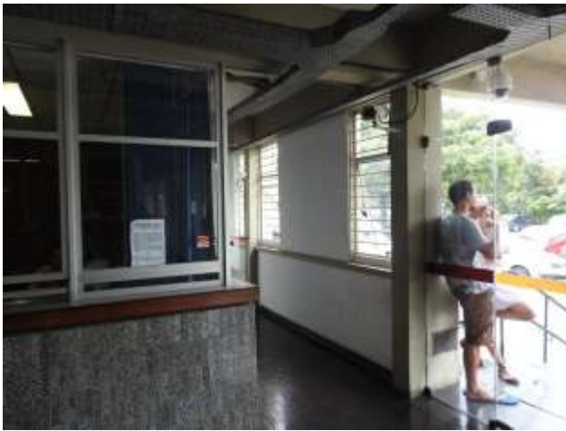
Porta na lateral direita da entrada principal
