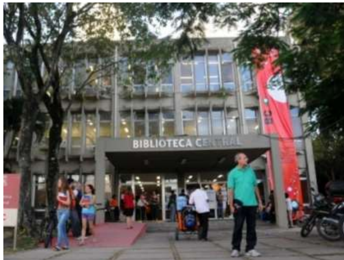
Entrada da Biblioteca Central
