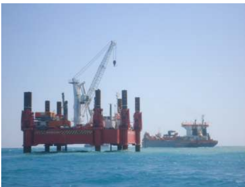
Figura 18 - Plataforma Wave Walker da Van Oord.
