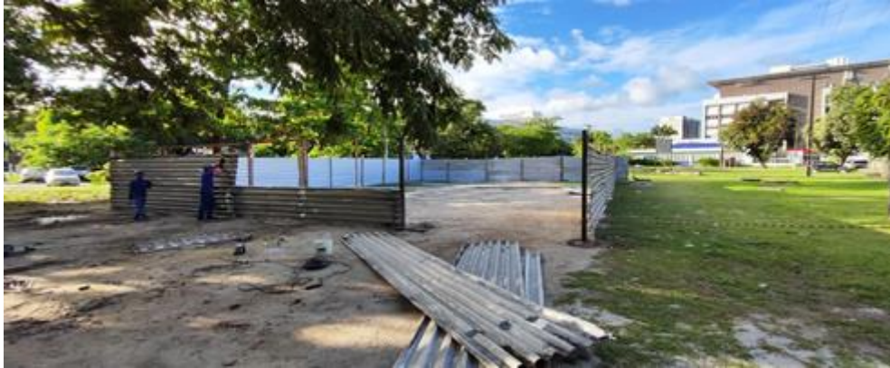
TAPUME COM TELHA METÁLICA. AF_05/2018
