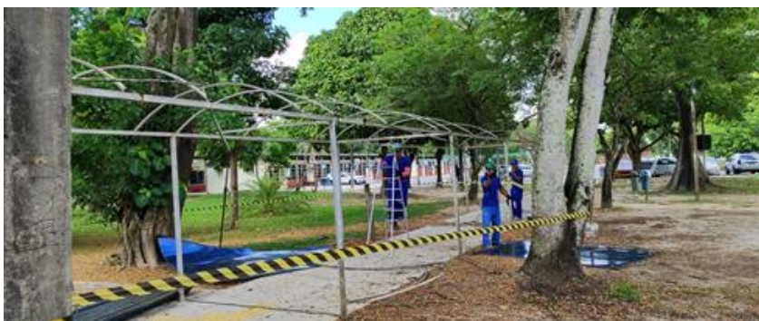
REMOÇÃO DE CHAPAS E PERFIS METÁLICOS DE FORMA MANUAL, SEM REAPROVEITAMENTO
