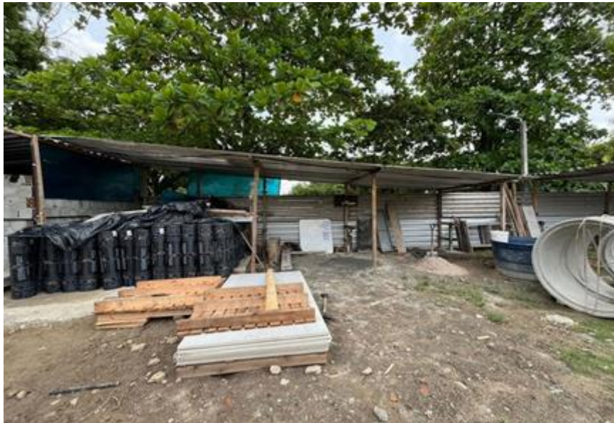
CENTRAL DE FÔRMAS, PRODUÇÃO DE ARGAMASSA OU CONCRETO EM CANTEIRO DE OBRA
