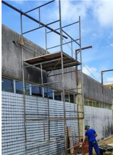
FORNECIMENTO E MONTAGEM DE LINHA DE VIDA COMPLETA, INCLUSIVE ACESSÓRIOS
