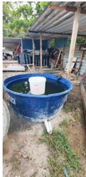
LIGAÇÃO PROVISÓRIA DE ÁGUA, INCLUSIVE CAIXA DE 1.000L
