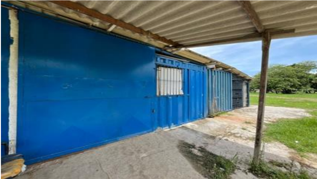
MOBILIZAÇÃO DE CONTAINER
