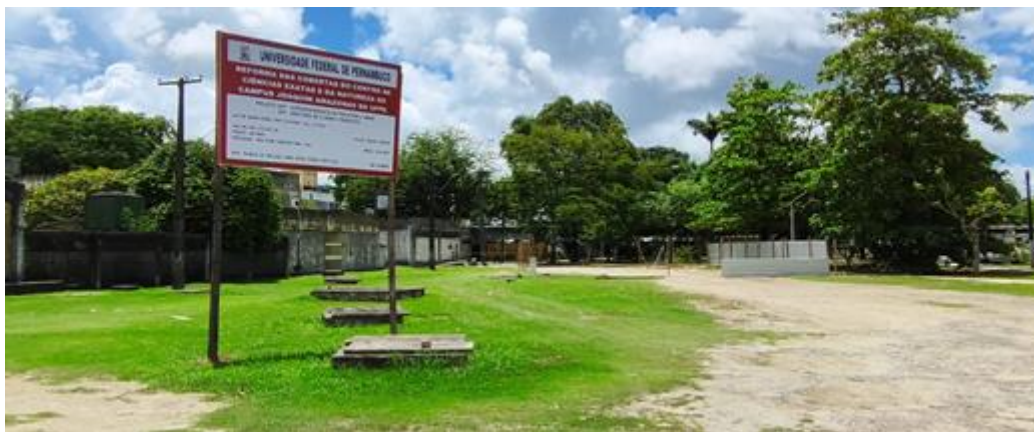
PLACA DE OBRA EM CHAPA DE AÇO GALVANIZADO -FORNECIMENTO E INSTALAÇÃO
