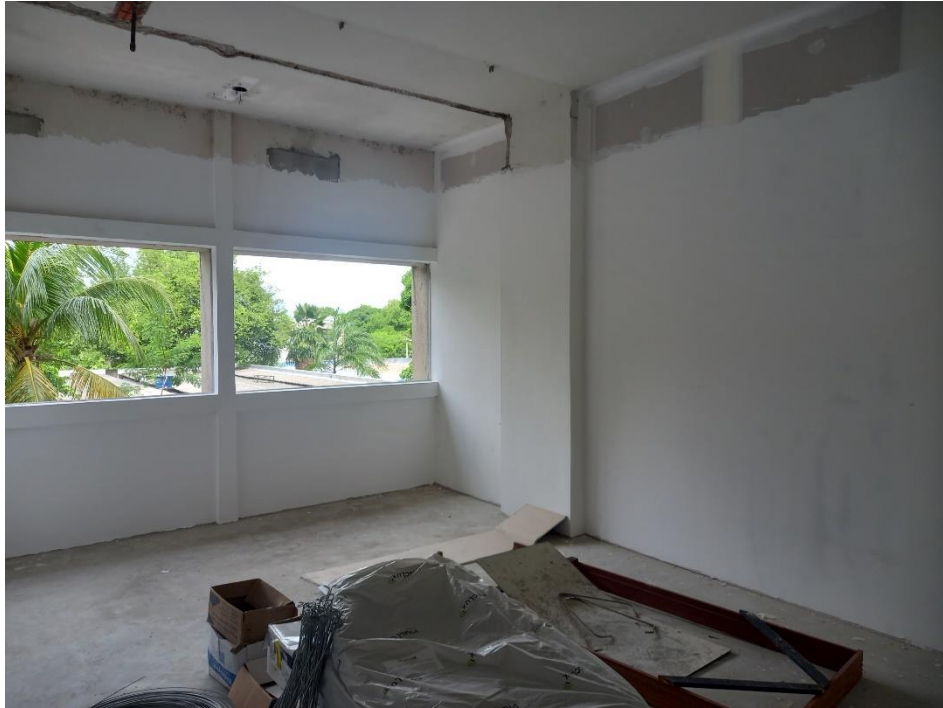
Figura 6 – Concluídas as divisórias
