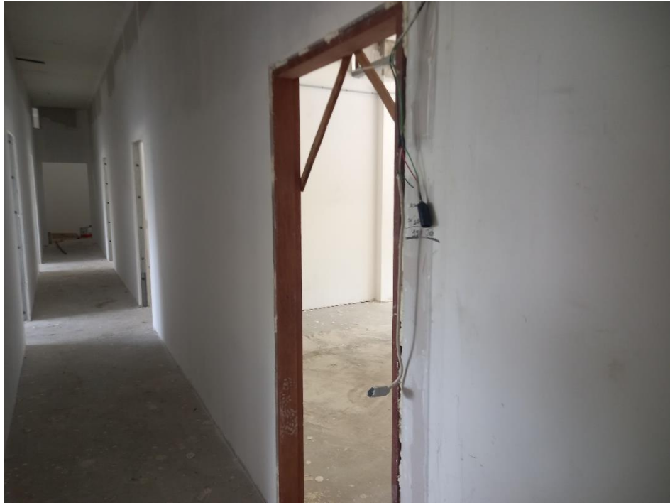
Figura 8 – Assentamento da grade de porta.
