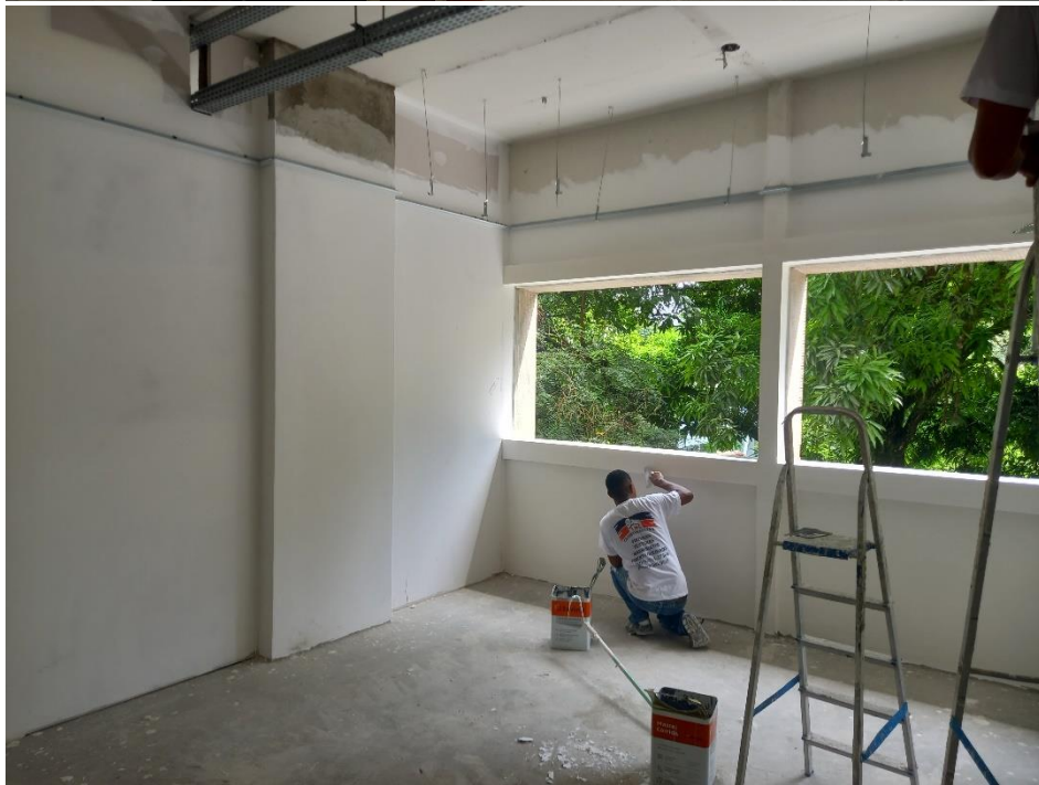
Figuras 4 e 5 – Concluídas as divisórias
