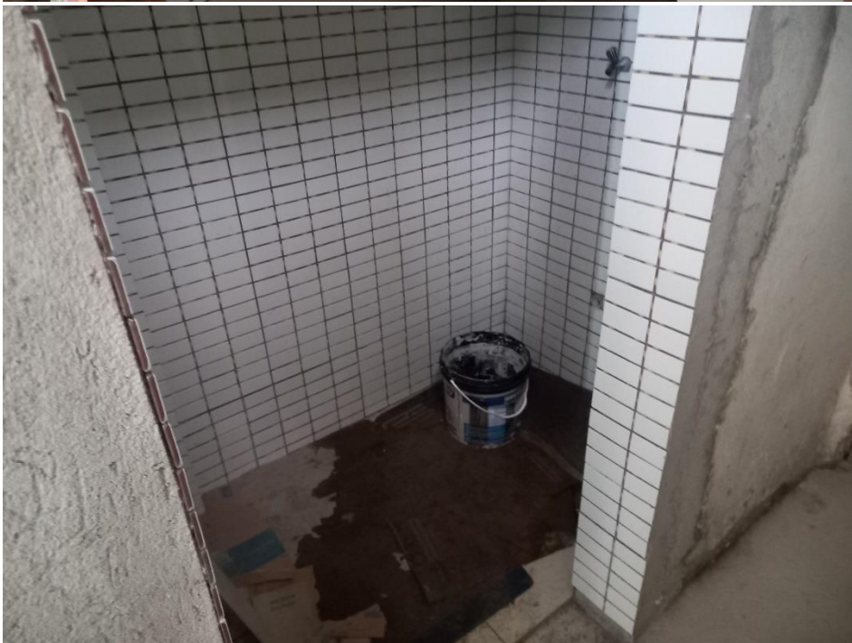
Figuras 1 e 2 - Finalização dos banheiros.
