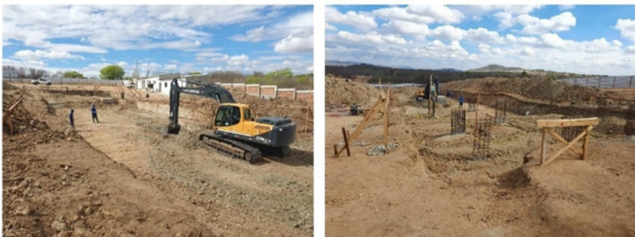
Obras em andamento para construção do Campus
