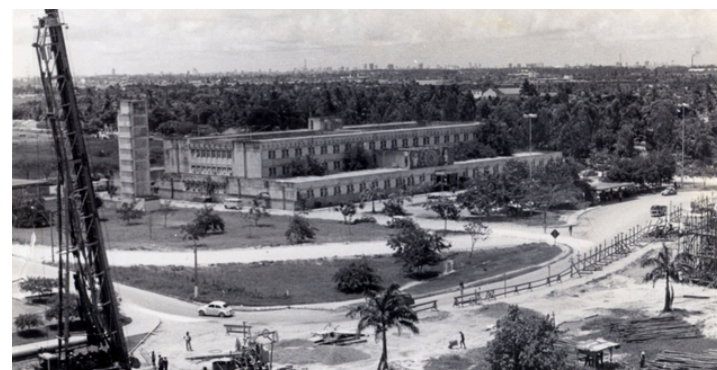
Construção do Campus Recife na década de 1940
