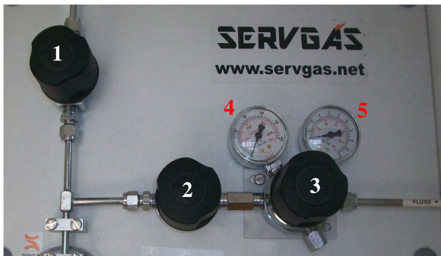
Figura 1. Central de gases Moriya. Os números representam: válvula de purga (1), válvula da central (2), válvula do regulador de pressão (3), manômetro de alta pressão (4) e manômetro de baixa pressão (5). Foto: Jéssica Moura.
