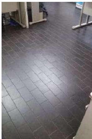
LOCAL: REITORIA SITUAÇÃO: ANTES
