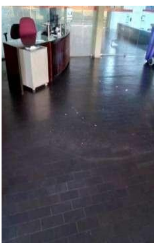
LOCAL: CCSA SITUAÇÃO: ANTES
