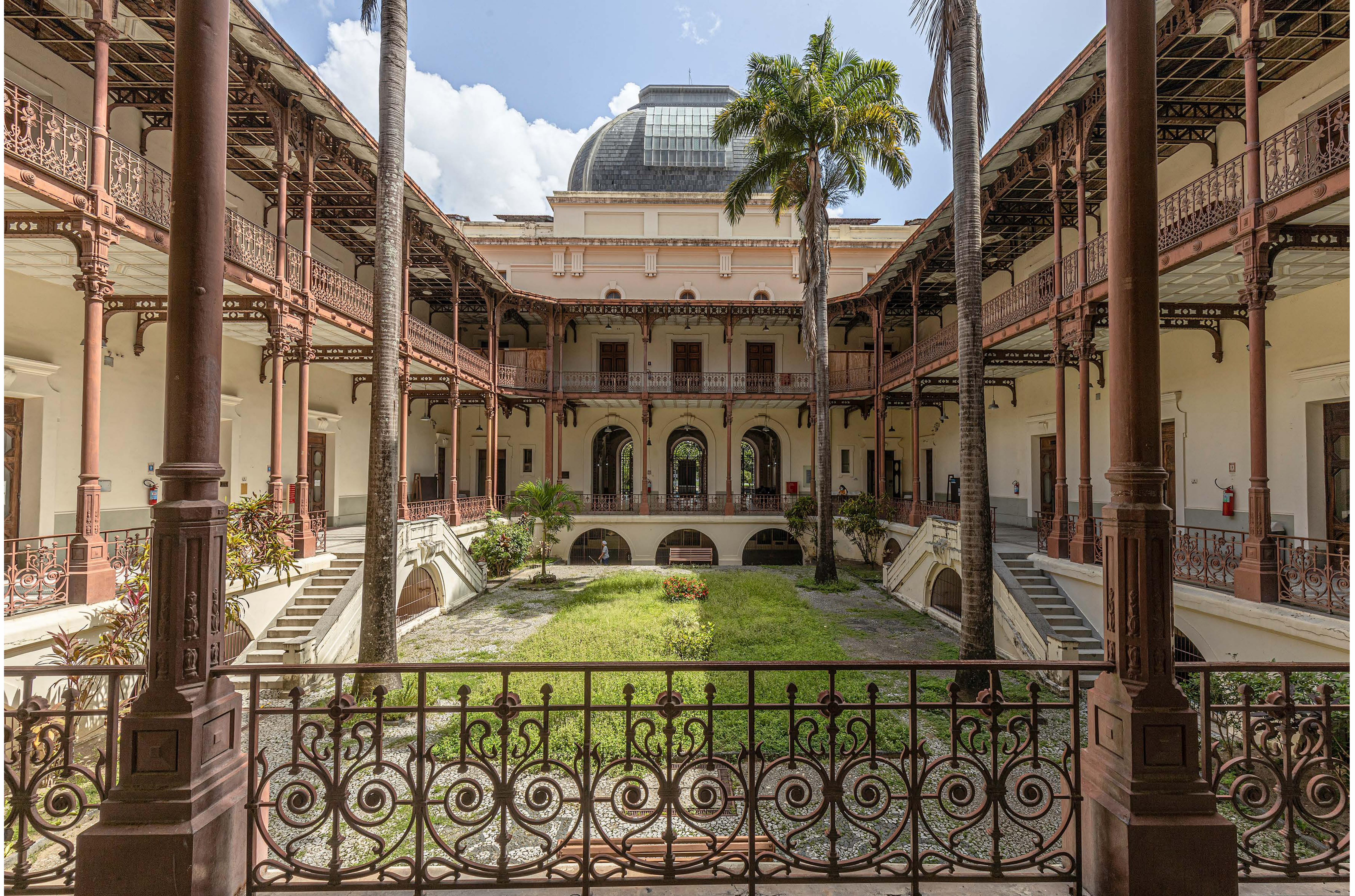
Figura 6 – Colunas e gradil que compõem o guarda-corpo do alpendre inferior
