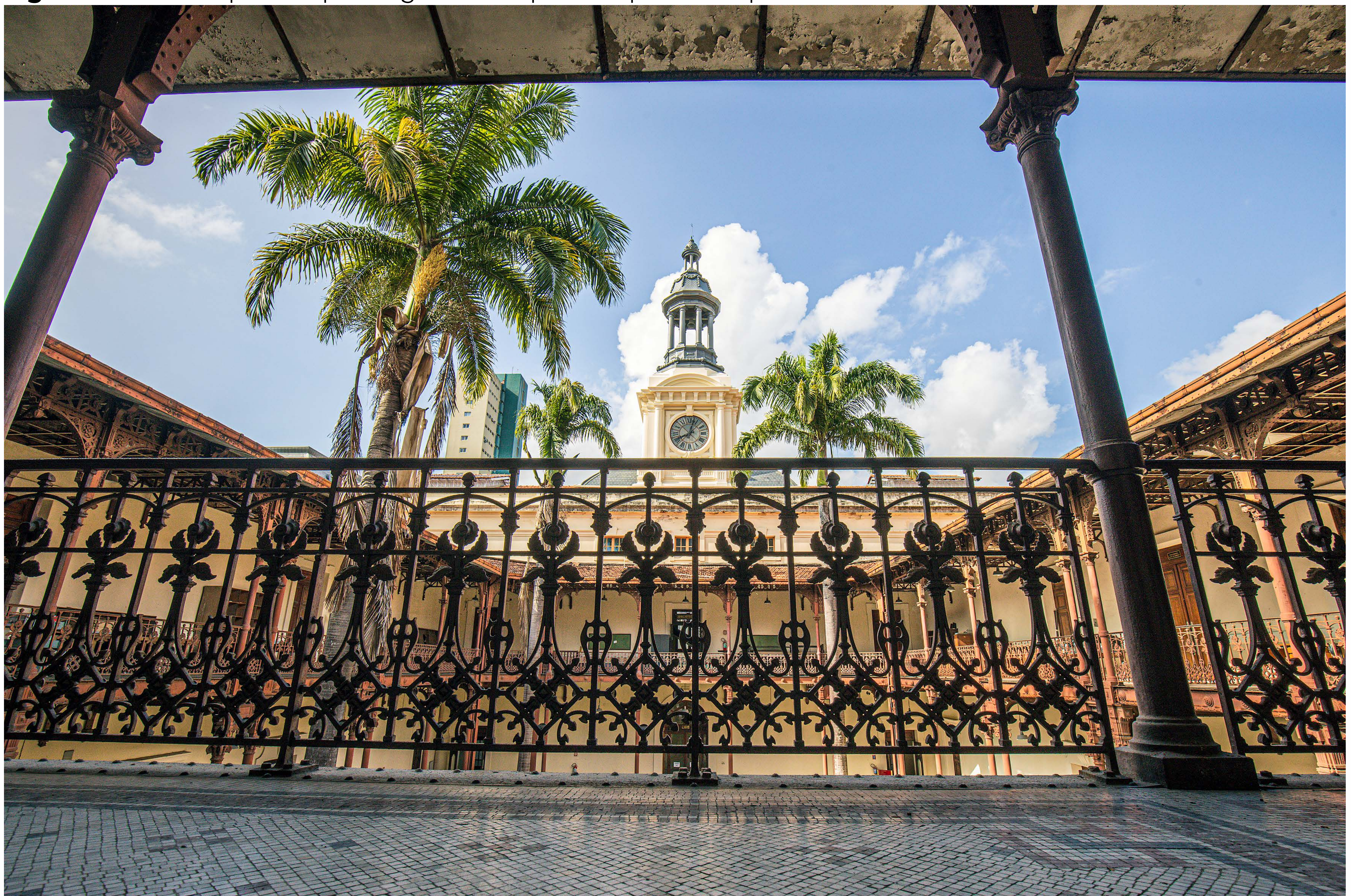
Figura 7 – Gradil que compõe o guarda-corpo do alpendre superior
