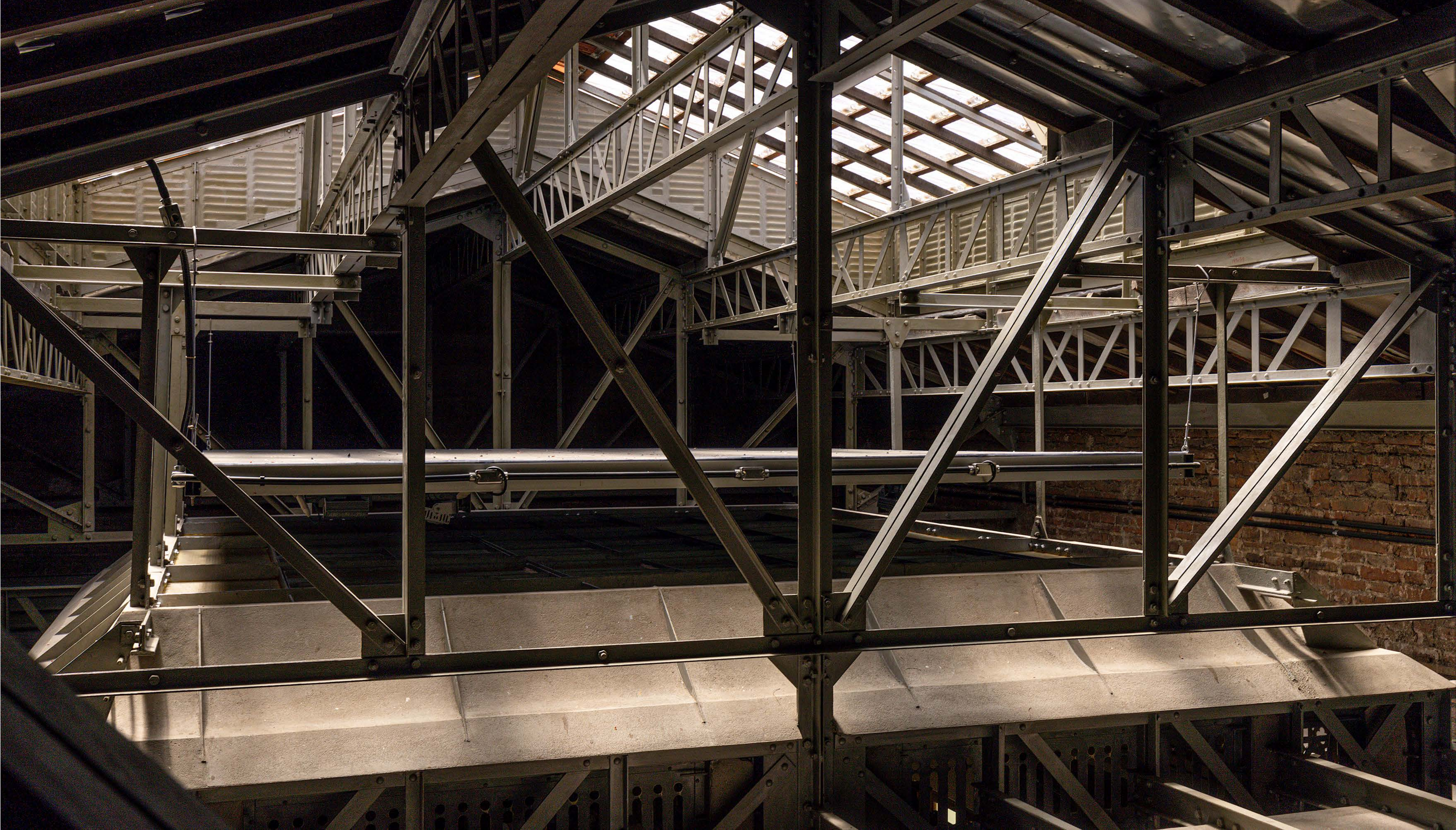
Figura 2 – Estrutura em aço e claraboia
