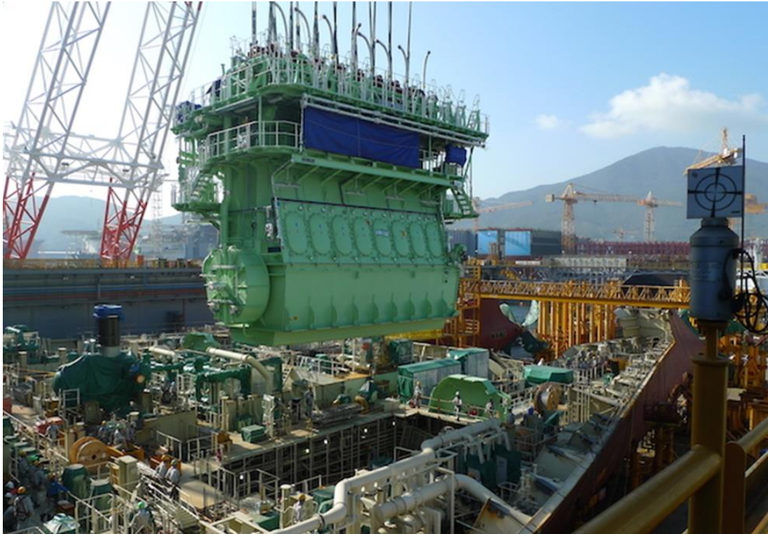
Figura 3 - Exemplo de Zona de Outfitting, neste caso uma Praça de Máquinas (Fonte: Marine Insight).
