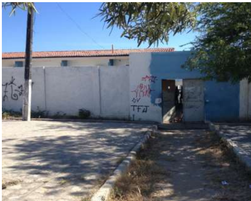
Figura 1: Fachada da escola Severino Cabral. Fonte: Sousa, J. M. F. de (2016).
