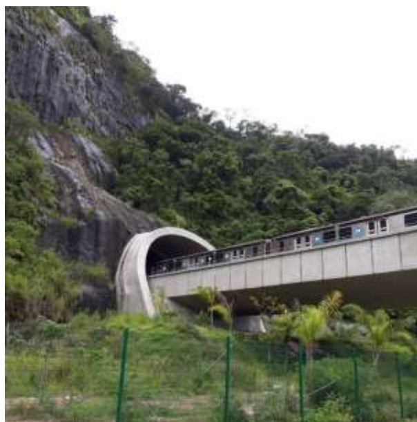
Figura 11 - Trecho da linha 4 do metrô do Rio de Janeiro. Fonte: Registrado pelos autores, 2018.
