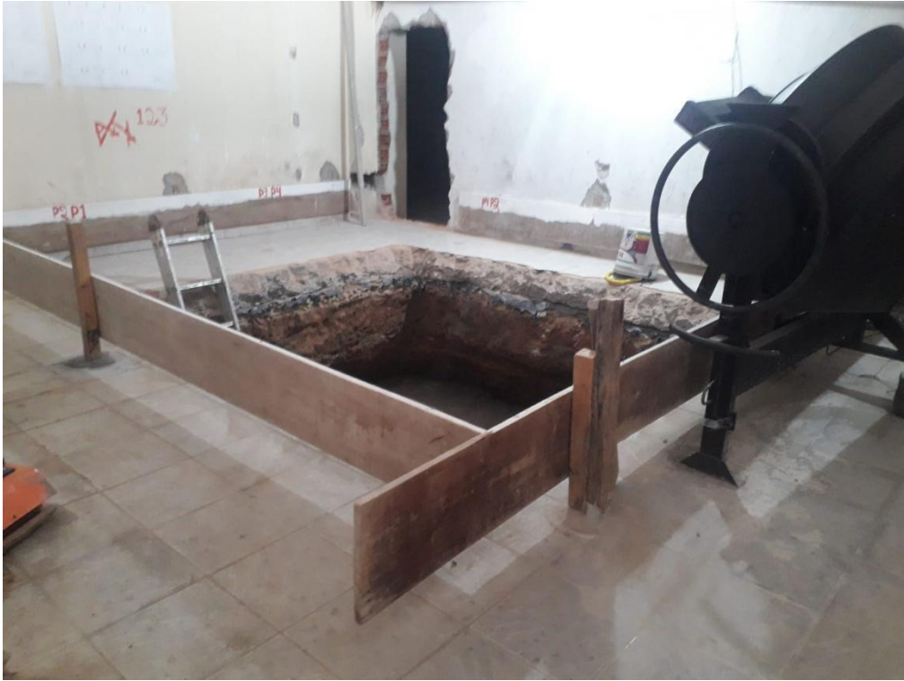
Figura 1 – Fundação da Caixa do Elevador.
