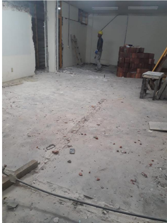
Figura 5 – Retirada de Paredes da sala térreo.
