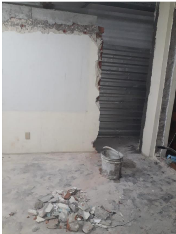
Figura 6 – Retirada da alvenaria – sala térreo.
