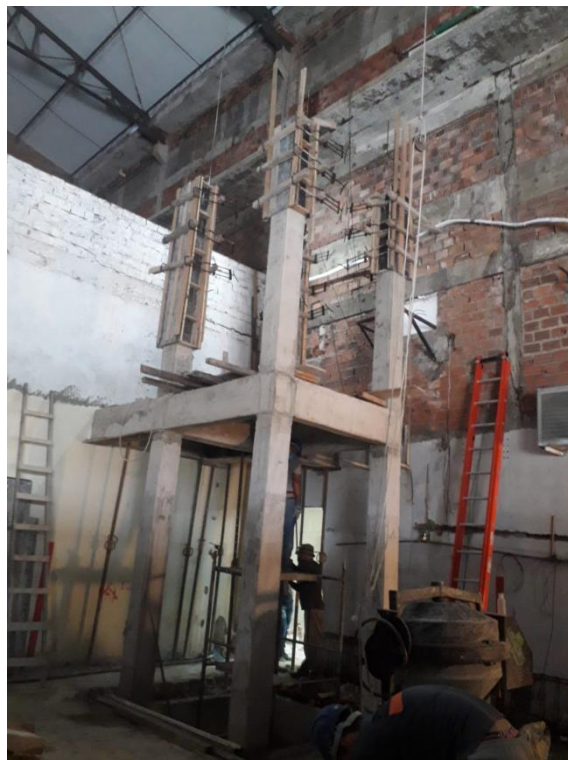
Figura 4 – Pilares concretados.
