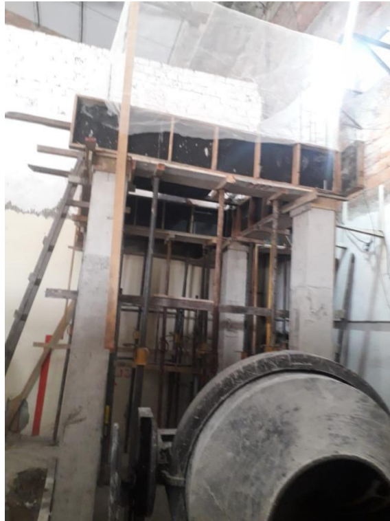
Figura 3 – Pilares concretados.
